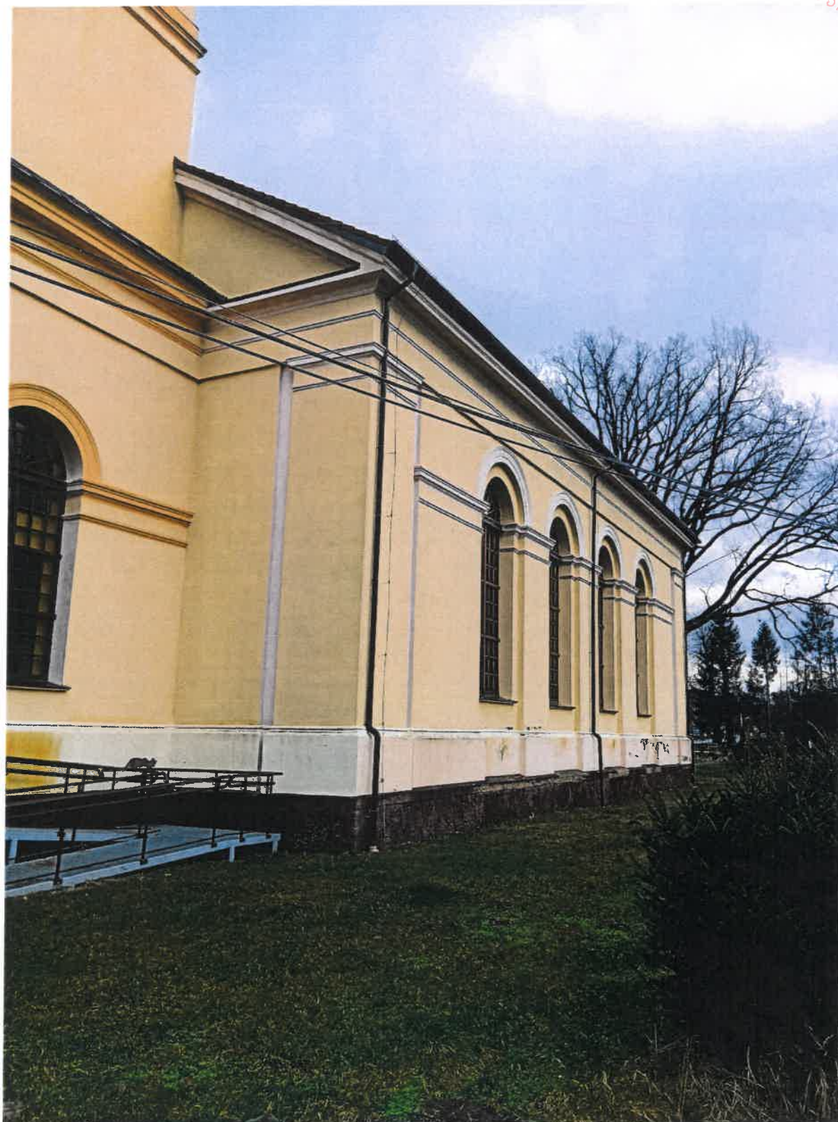
Fot. 5. Widok elewacji od strony południowo –zachodniej
