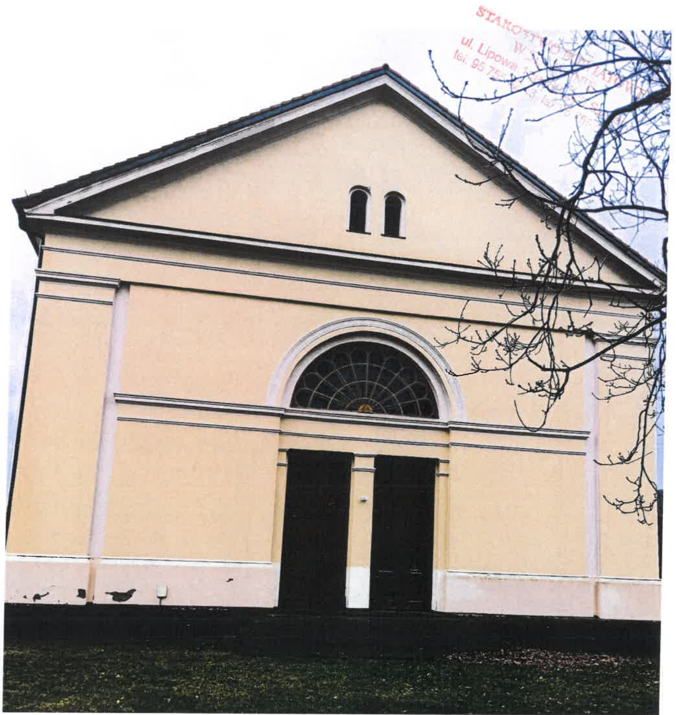
Fot. 2. Widok elewacji kościoła od strony wschodniej.
