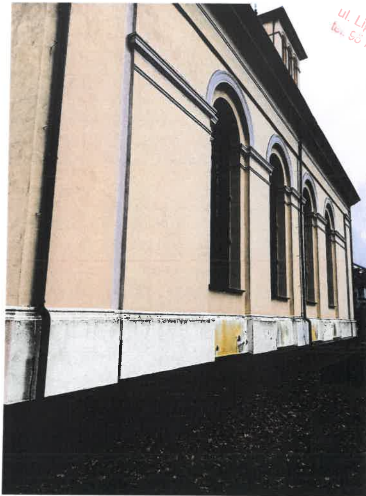
Fot. 3. Widok elewacji od strony północno – wschodniej
