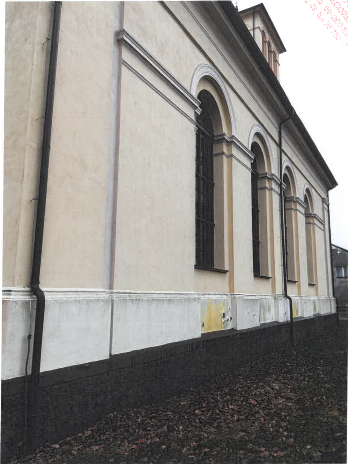
Fot. 3. Widok elewacji od strony północno –wschodniej
