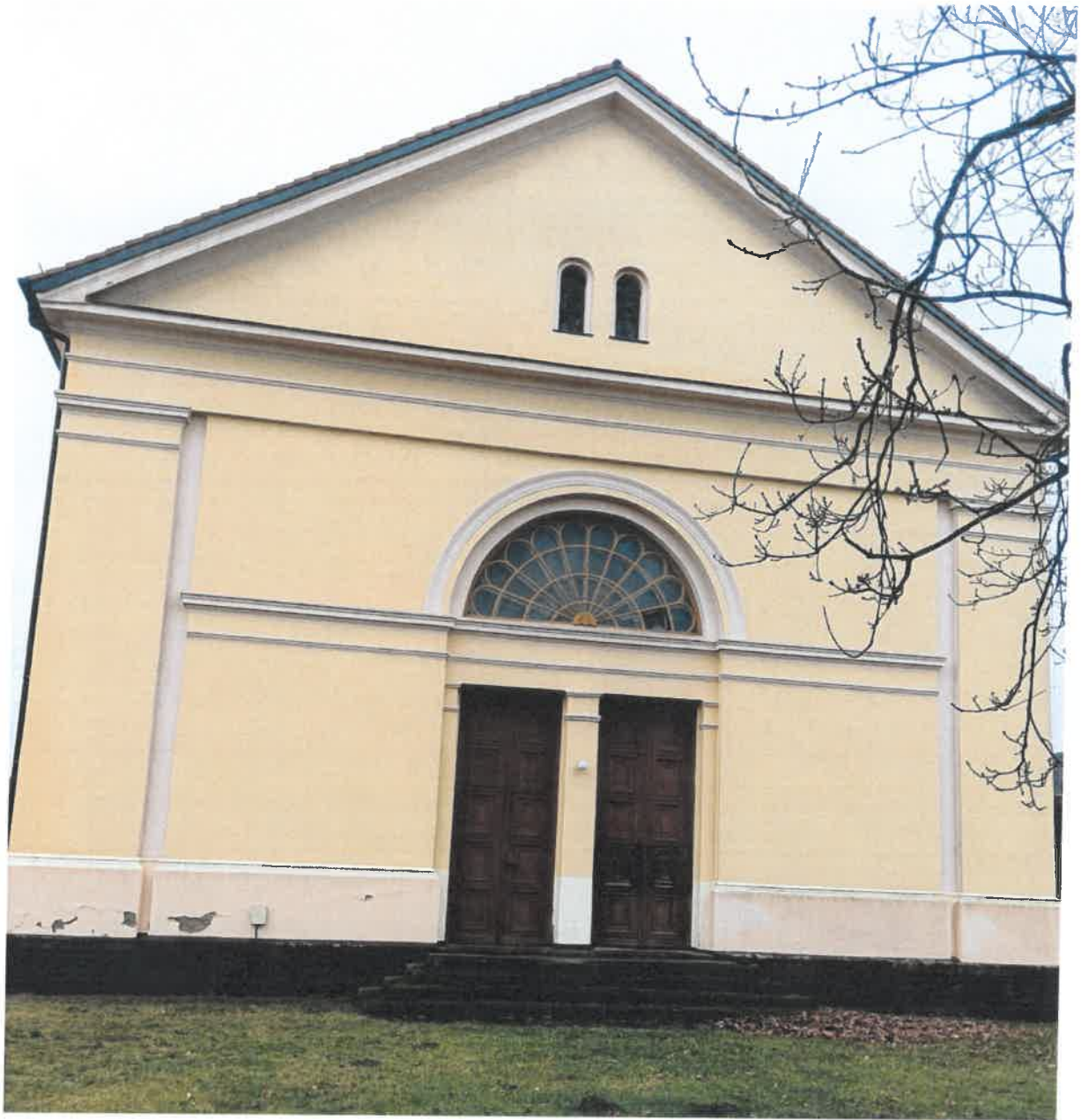
Fot. 2. Widok elewacji kościoła od strony wschodniej
