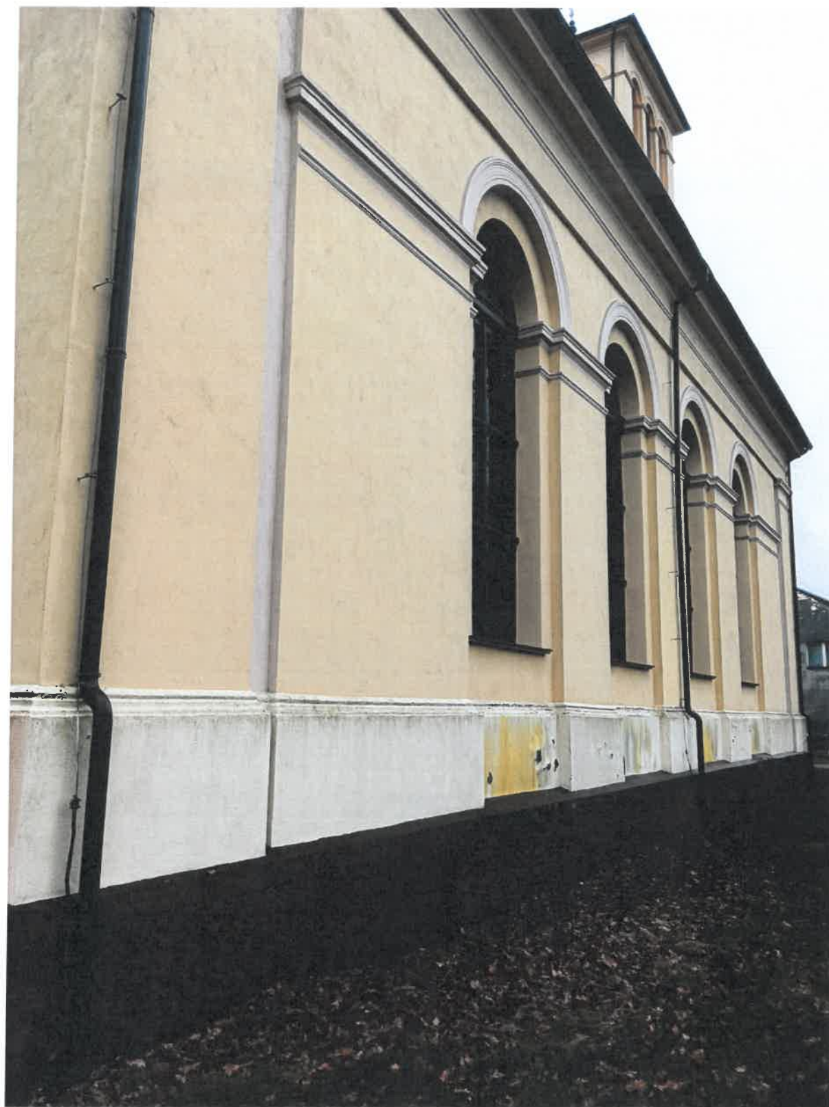
Fot. 3. Widok elewacji od strony północno –wschodniej
