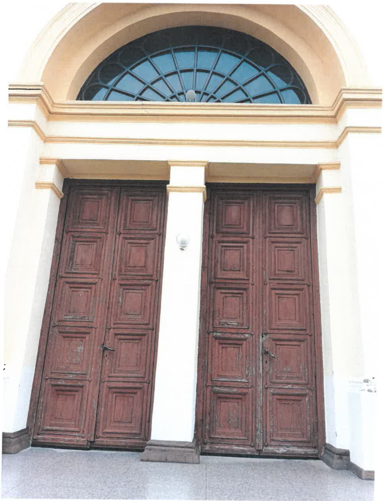
Fot. 9. Elewacja zachodnia - drzwi wejściowe do kościoła przewidziane do renowacji
