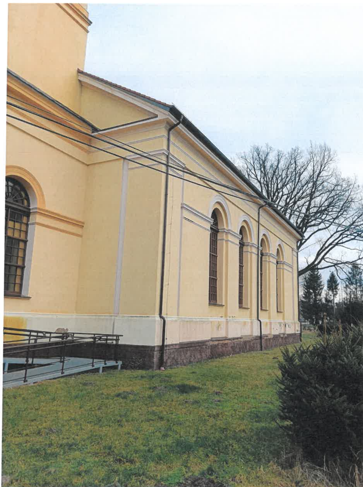
Fot. 5. Widok elewacji od strony południowo –zachodniej
